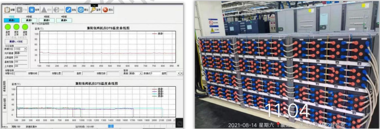
图 四- 4 软件界面及项目现场电池组
